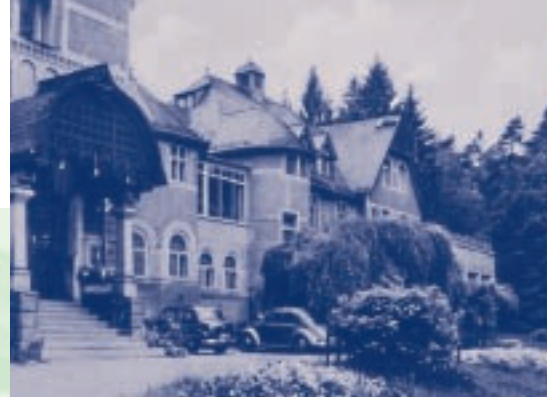
Eingangstreppe Haus Feldberg und rechts Haus Saalburg.
