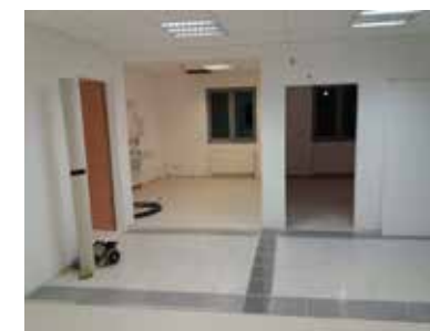
Umbauarbeiten im Erdgeschoss von Haus Taunus
